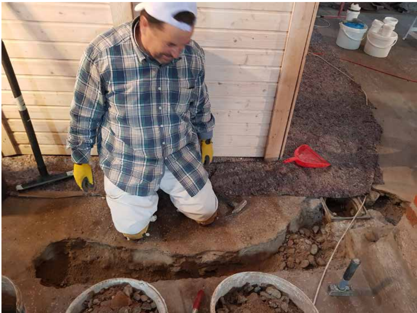
Restauro dei pavimenti in battuto cementizio
