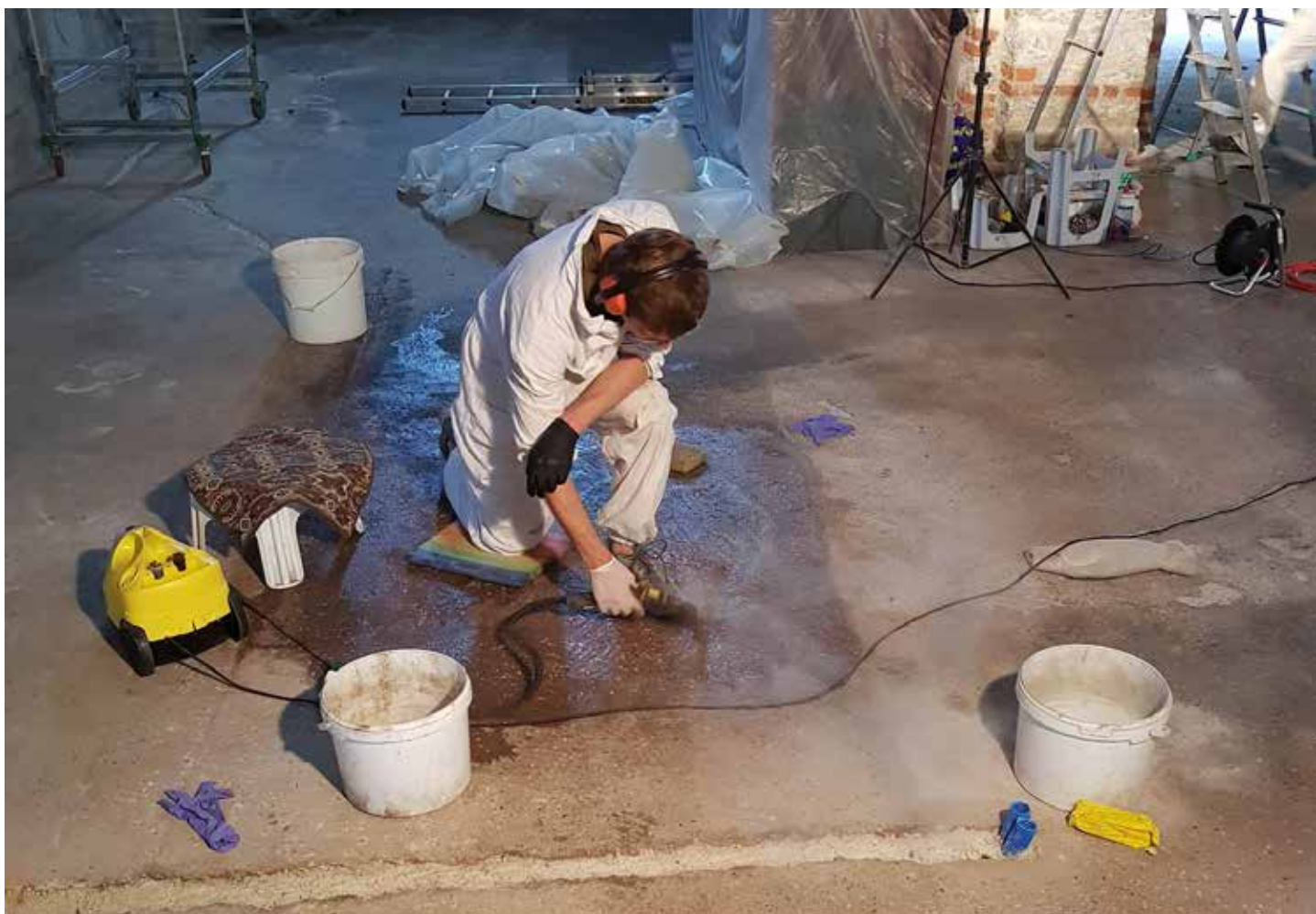
Restauro dei pavimenti in battuto cementizio con inserimento impianti
