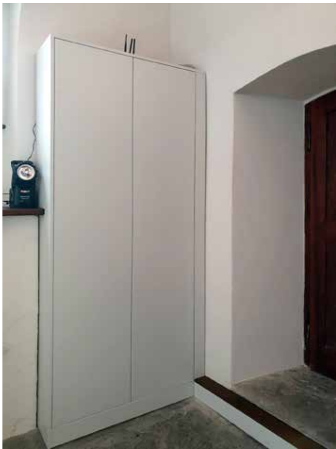
Nuovo quadro elettrico in sacrestia
