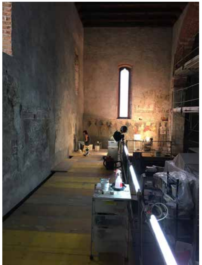
Restauri parete meridionale
