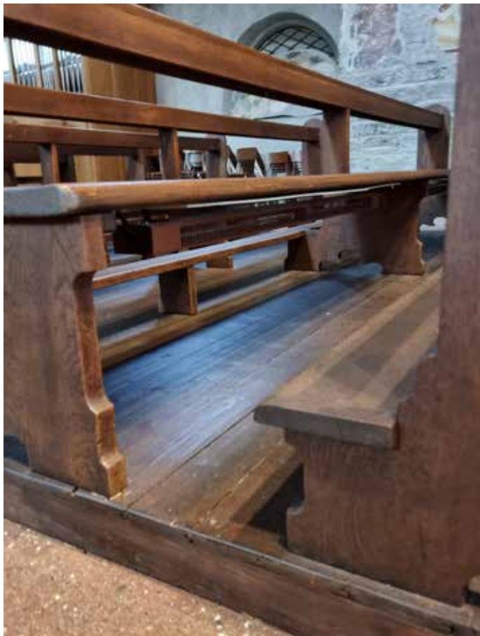
Nuovi corpi riscaldanti sotto i banchi
