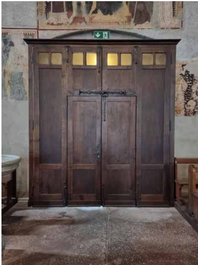
Bussola ingresso entrata principale
