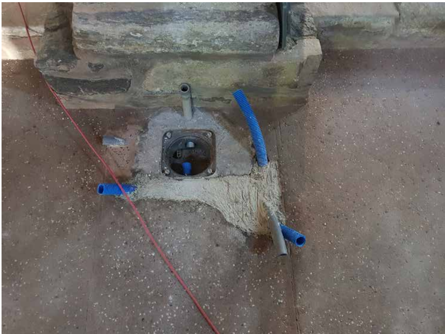
Restauro dei pavimenti in battuto cementizio con inserimento impianti
