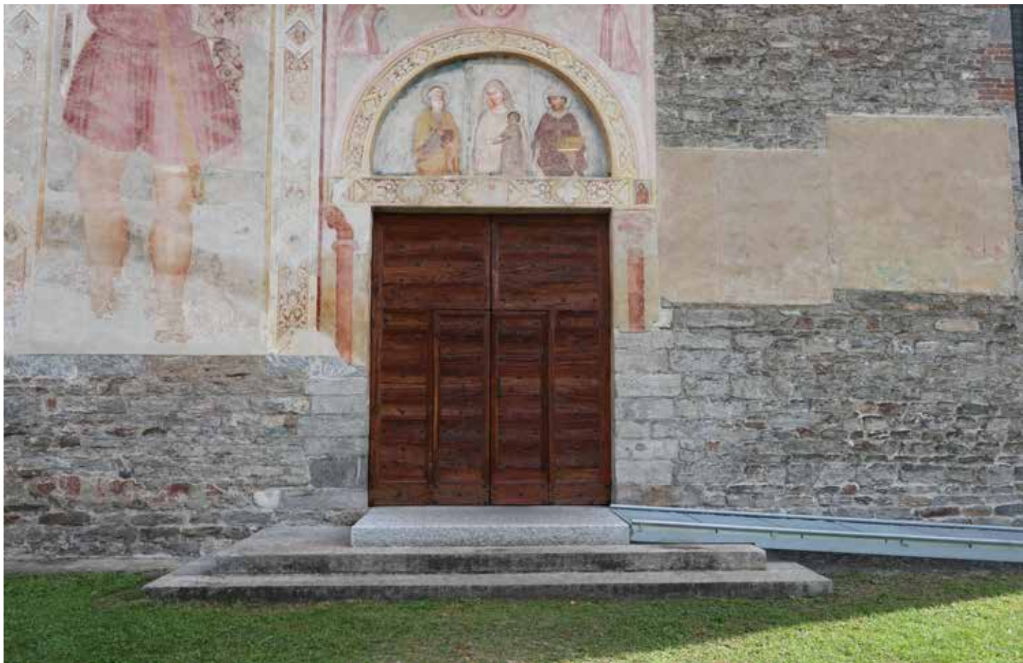
Porta d'ingresso prinvipale
