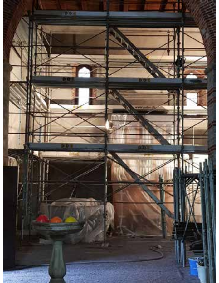
Ponteggi navata nord
