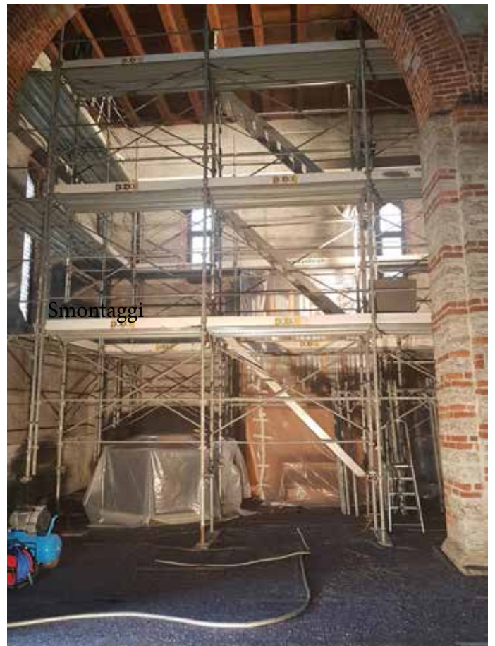
Ponteggi navata nord
