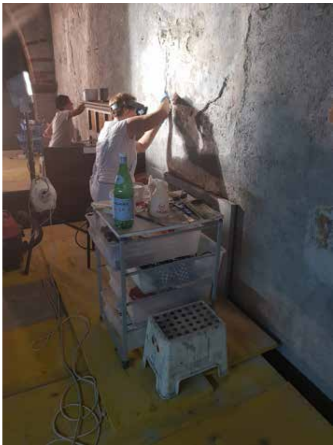
Restauri parete meridionale
