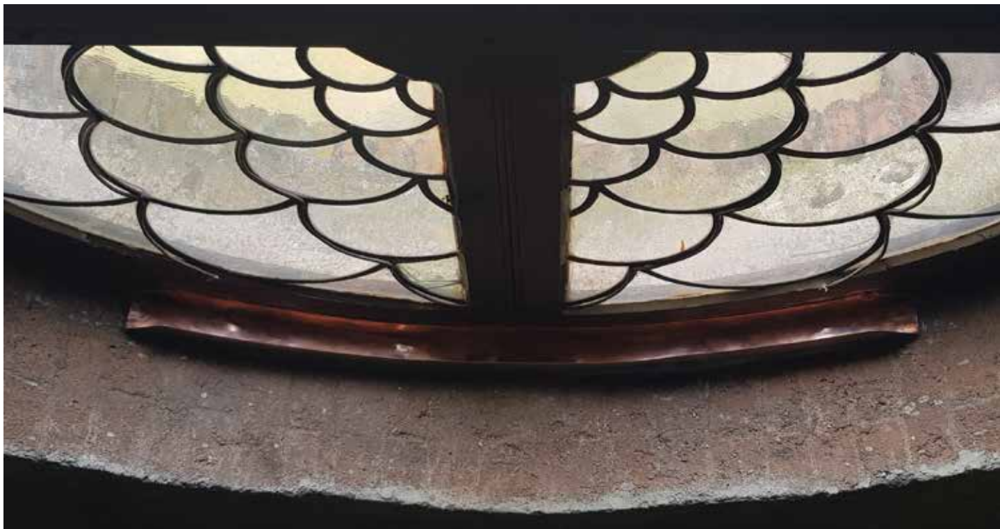
Canalina per raccogliere l'acqua sul rosone in controfacciata
