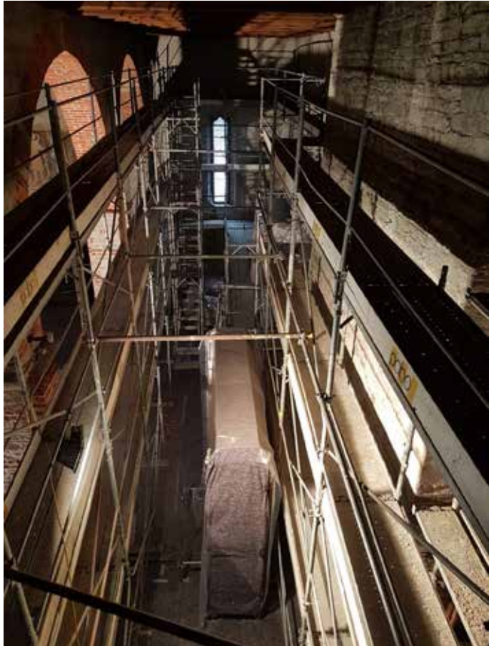
Ponteggi navata nord
