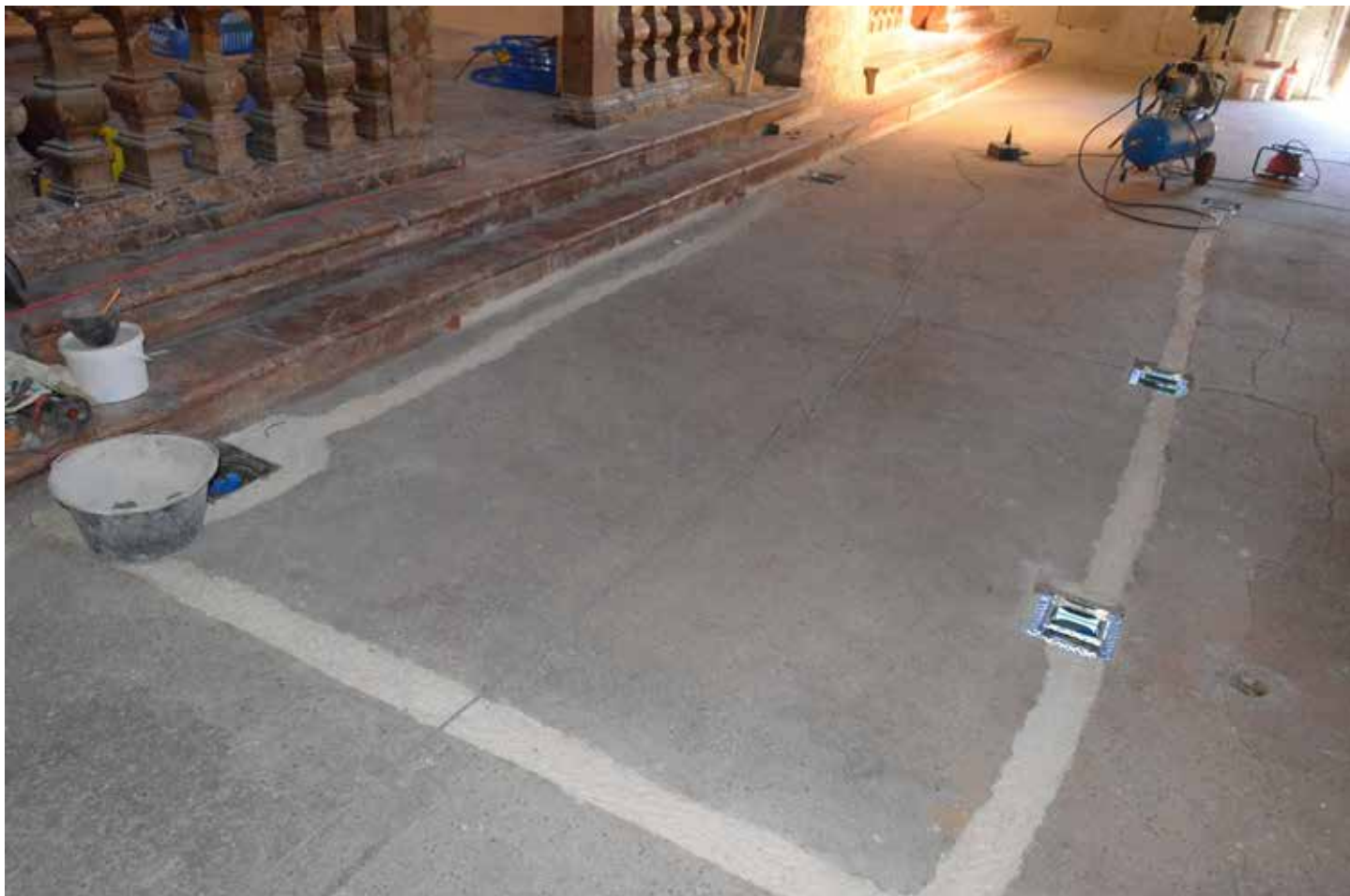
Restauro dei pavimenti in battuto cementizio con inserimento impianti
