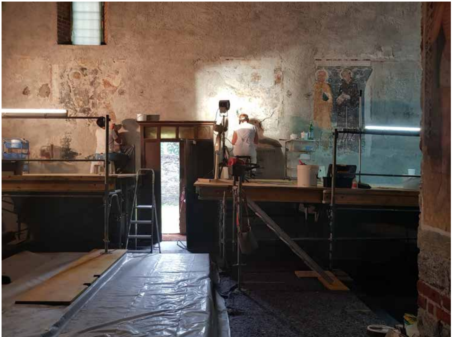
Restauri parete meridionale
