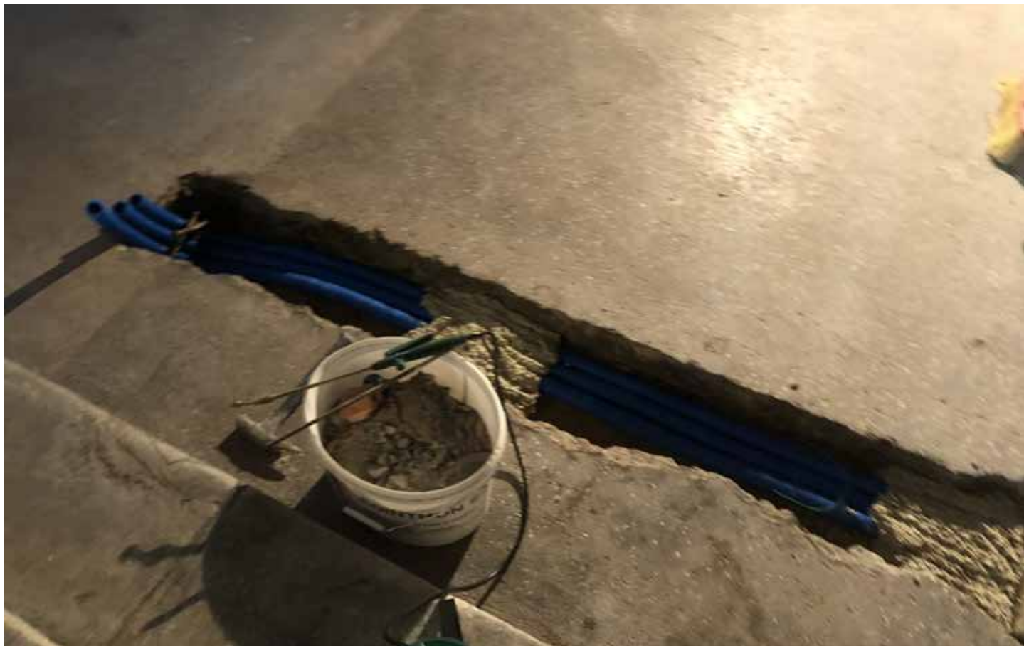
Restauro dei pavimenti in battuto cementizio con inserimento impianti
